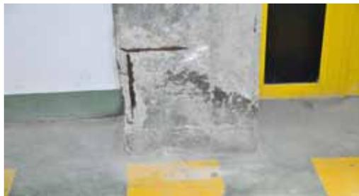
La limpieza del óxido de las armaduras se realiza mediante: chorreado de silicato de aluminio, pistola de agujas o cepillo de alambre.
