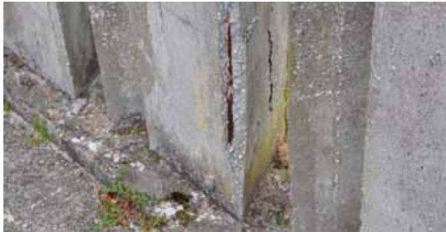
La humedad de capilaridad en estructuras de hormigón armado, se manifiesta habitualmente en elementos en contacto con el terreno.
